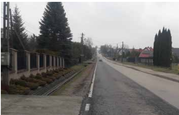
Droga w Kaszowie przed i po remoncie
