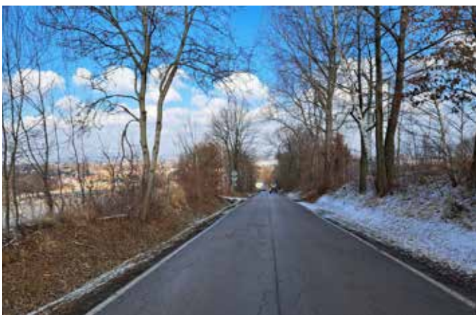
Droga w Krzęcinie przed i po remoncie
