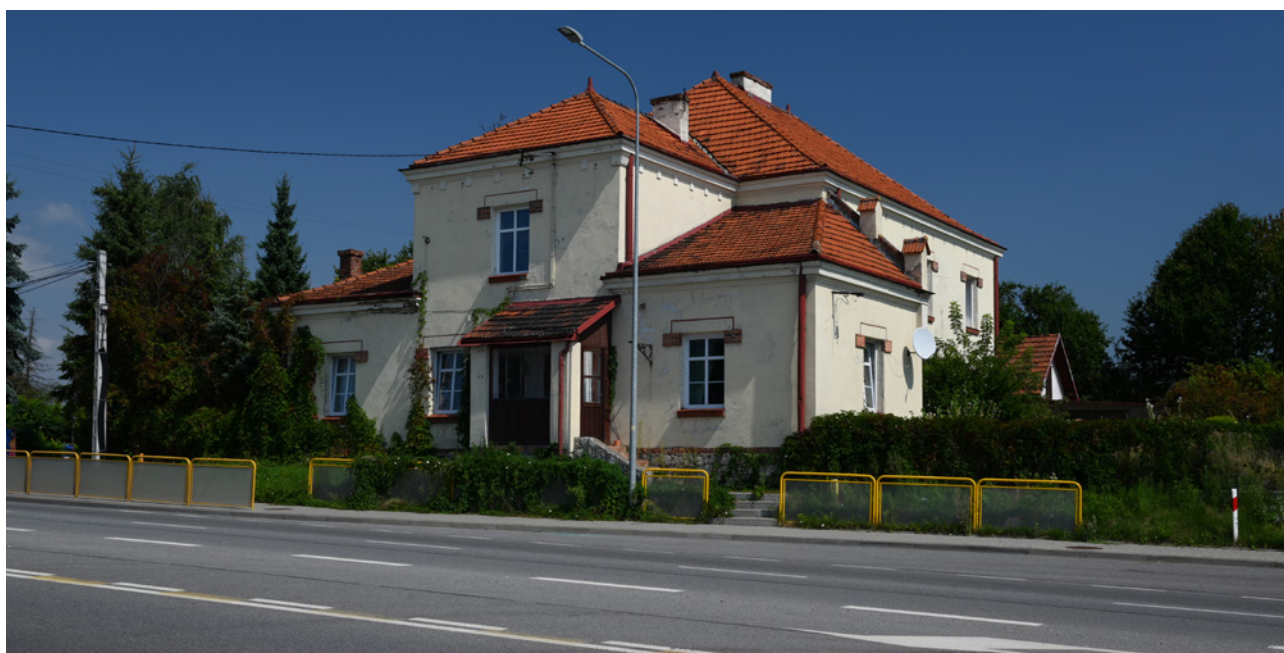
Budynek dawnej komory celnej w Modlnicy ; zdjęcie: Krzysztof Kamiński
