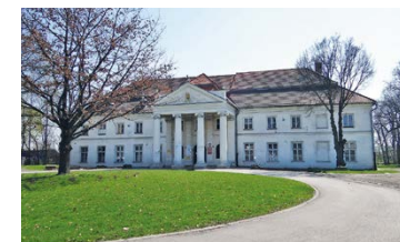
Pałac Wodzickich w Niedźwiedziu, fot. © Radosław Dybala
